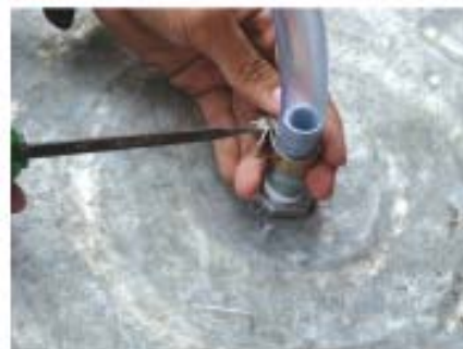
สายยางขนาด 4 ฟุต ยาว 4 เมตร มาสวมใส่ปลายทางปลาและใช้เข็มขัดรัดให้แน่น
