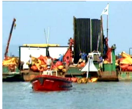
สายเคเบิลใต้น้ำที่ขุดเป็นวงในวงล้อที่อยู่บนเรือท้องแบน
