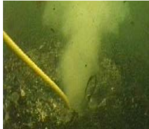
เครื่อง water jets ขณะทำงานใต้ทะเล
