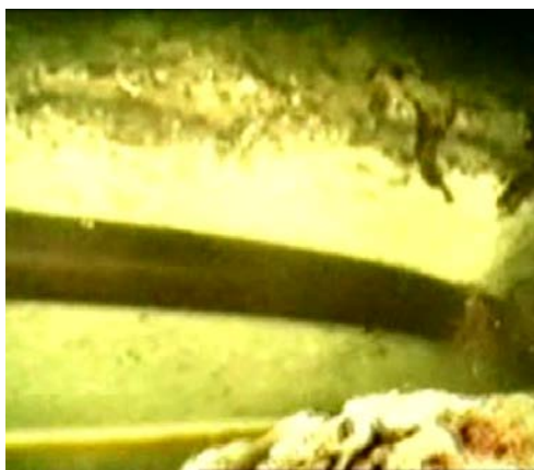
สายเคเบิลใต้น้ำที่ตกลงในหลุมที่เกิดจากการเป่าด้วยเครื่อง water jets
