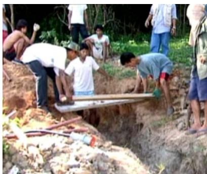
ขั้นตอนที่ 11 การฝังกลบสายเคเบิลใต้น้ำบนฝั่ง ซึ่งจะกระทำเหมือนกันทั้งสองฝั่ง
