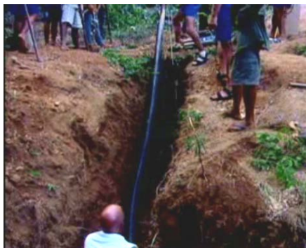
ขั้นตอนที่ 10 วัดความยาวของสายเคเบิลใต้น้ำและติดตั้งสายเคเบิลใต้น้ำเข้ากับ จุดขึ้น-ลง
