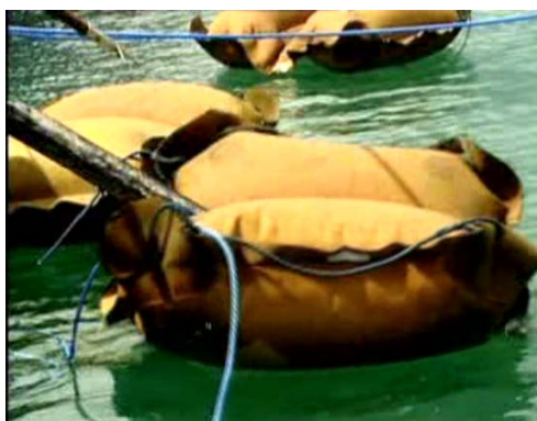
การลากสายเคเบิลใต้น้ำโดยเรือเล็กจากเรือท้องแบนเข้าฝั่งโดยที่มีถุงลมรองรับ
