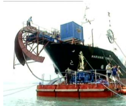
ขั้นตอนที่ 3 เรือใหญ่จะจอดลอยลำอยู่ในบริเวณที่ลึก และใช้เรือเล็กลากสายเคเบิลใต้น้ำเข้าฝั่ง
