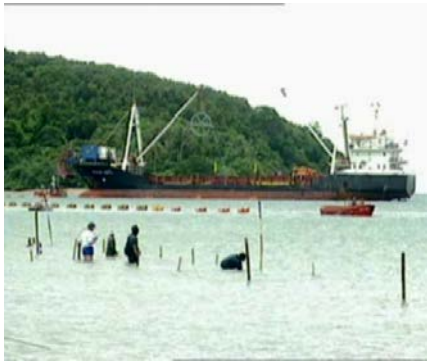
ขั้นตอนที่ 3 เรือใหญ่จะจอดลอยลำอยู่ในบริเวณที่ลึก และใช้เรือเล็กลากสายเคเบิลใต้น้ำเข้าฝั่ง
