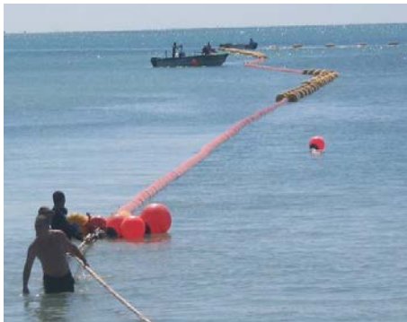
ขั้นตอนที่ 4 ลากสายเคเบิลใต้น้ำจากเรือใหญ่เข้าฝั่ง โดยที่มีถุงลมรองรับสายเคเบิลใต้น้ำ
