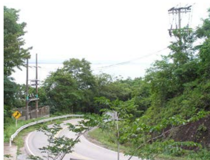
ภาพที่ 2-15 ลักษณะเสาไฟฟ้าที่เชื่อมต่อจากจุดรับสายเคเบิลใต้น้ำเพื่อจ่ายไฟฟ้าให้กับชุมชน
