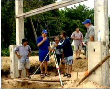
ขั้นตอนที่ 1 ก่อสร้าง จุดขึ้น-ลง บนฝั่งเพื่อเป็นจุดรองรับสายเคเบิลใต้น้ำ
