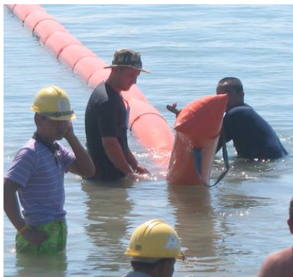
ขั้นตอนที่ 5 ดึงสายเคเบิลใต้น้ำขึ้นฝั่งไปยัง จุดขึ้น-ลง เพื่อยึดสายและติดตั้งสายเคเบิลใต้น้ำ
