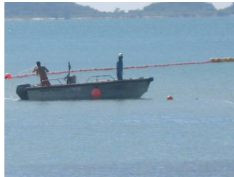
ขั้นตอนที่ 4 ลากสายเคเบิลใต้น้ำจากเรือใหญ่เข้าฝั่ง โดยที่มีถุงลมรองรับสายเคเบิลใต้น้ำ
