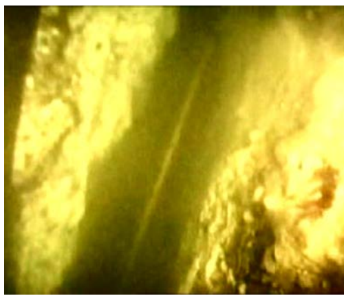
สายเคเบิลใต้น้ำที่ตกลงในหลุมที่เกิดจากการเป่าด้วยเครื่อง water jets
