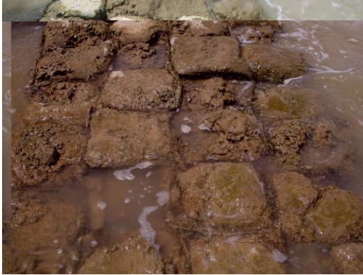
ภาพที่ 2-11 วิธีการฝังสายเคเบิลใต้น้ำบริเวณพื้นหินในที่ตื้น
