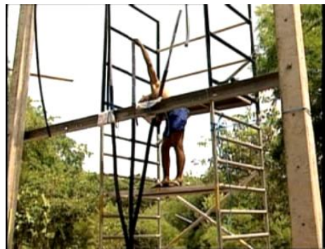
ขั้นตอนที่ 10 วัดความยาวของสายเคเบิลใต้น้ำและติดตั้งสายเคเบิลใต้น้ำเข้ากับ จุดขึ้น-ลง
