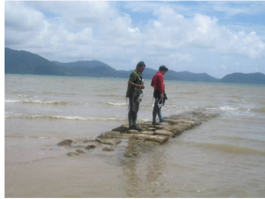
ภาพที่ 2-11 วิธีการฝังสายเคเบิลใต้น้ำบริเวณพื้นหินในที่ตื้น
