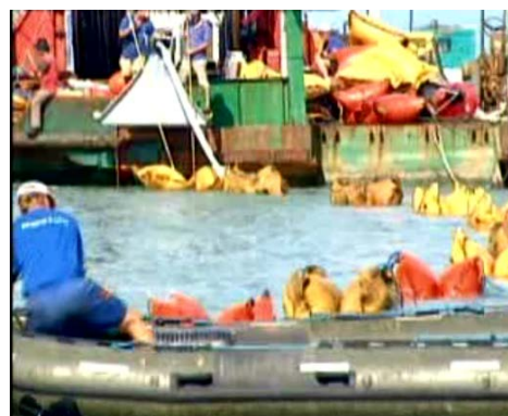
การลากสายเคเบิลใต้น้ำโดยเรือเล็กจากเรือท้องแบนเข้าฝั่งโดยที่มีถุงลมรองรับ
