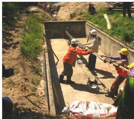
ขั้นตอนที่ 5 ดึงสายเคเบิลใต้น้ำขึ้นฝั่งไปยัง จุดขึ้น-ลง เพื่อยึดสายและติดตั้งสายเคเบิลใต้น้ำ
