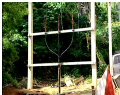
ขั้นตอนที่ 11 การฝังกลบสายเคเบิลใต้น้ำบนฝั่ง ซึ่งจะกระทำเหมือนกันทั้งสองฝั่ง
