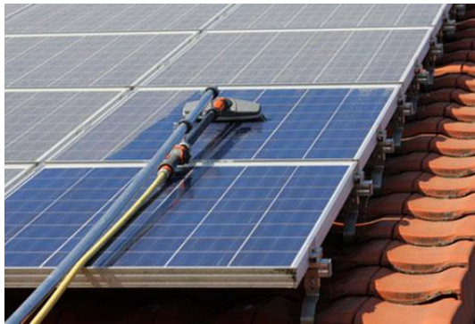
รูปที่ 3-1 ตัวอย่างการทำความสะอาดแผงเซลล์แสงอาทิตย์
