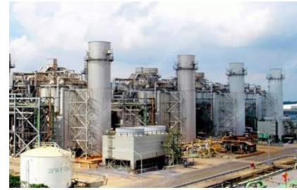
โรงไฟฟ้าราชบุรี
